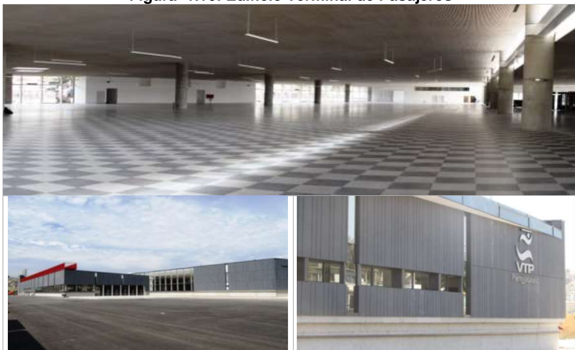
Figura 1.16: Edificio Terminal de Pasajeros
