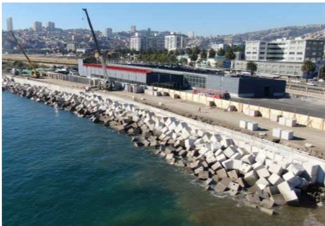
Figura 10: Imagen construcción escolleras
